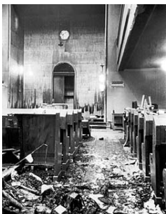
Blick in die zerstörte Synagoge in der Reichenbachstraße. FOTO: SZ
